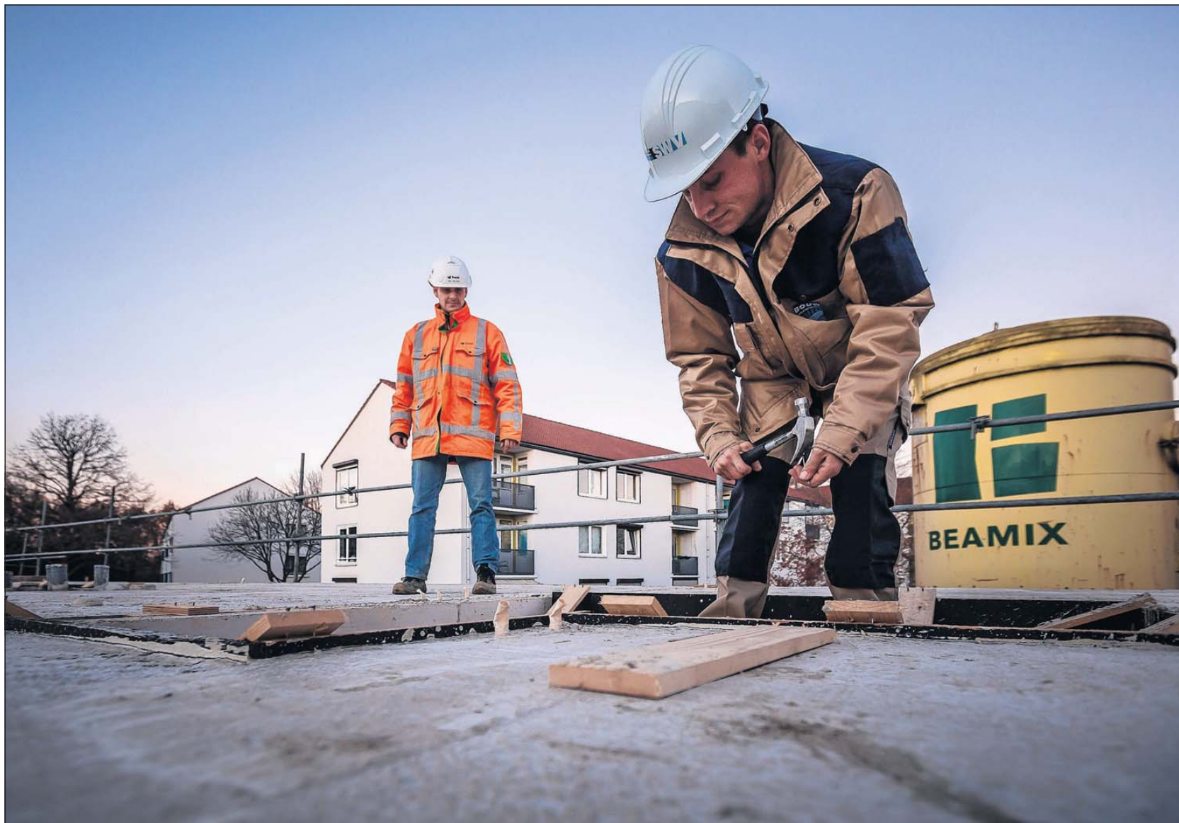
Geert Scholl (voorgrond) werkt onder het toezien van uitvoerder Paul Dielissen aan een nieuwbouwproject in Kerkrade.
