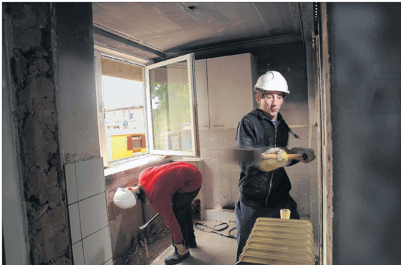
Alex Febo (rechts) en Roy Weber aan het werk in een sloopwoning aan de Gladiolenstraat in Kerkrade.
